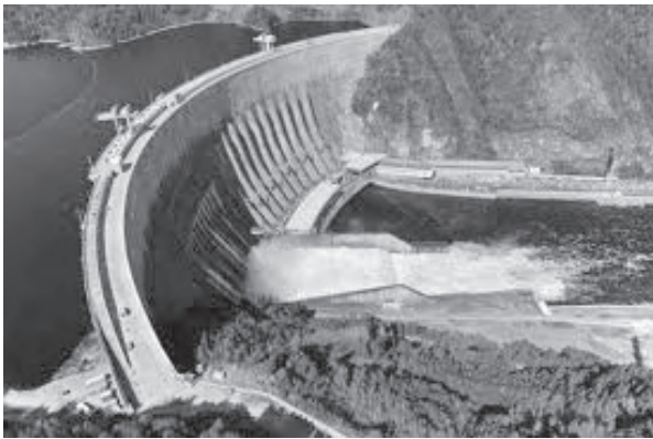
รูปภาพ แสดงเขื่อน (Dam) ขนาดใหญ่ และภาพแสดงการไหลของน้ำระดับสูงของเขื่อนลงมาหมุนกังหันน้ำ (Turbine) นำกำลังที่ได้ไปหมุนเจเนอเรเตอร์ผลิตกระแสไฟฟ้า
