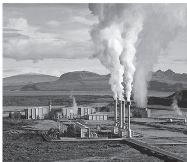
รูปภาพ แสดงสถานที่ตั้งโรงไฟฟ้าที่ใช้พลังงานความร้อนใต้ดิน เมื่อนำมาทำไอน้ำหมุน Steam Turbine ส่งกำลังมาหมุน Generator ผลิตกระแสไฟฟ้า
